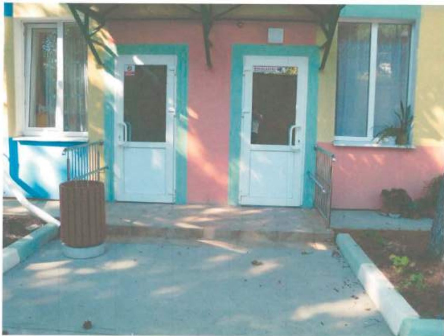
Фото 13 На плане отмечено 13 Описание: вход в здание № 2
