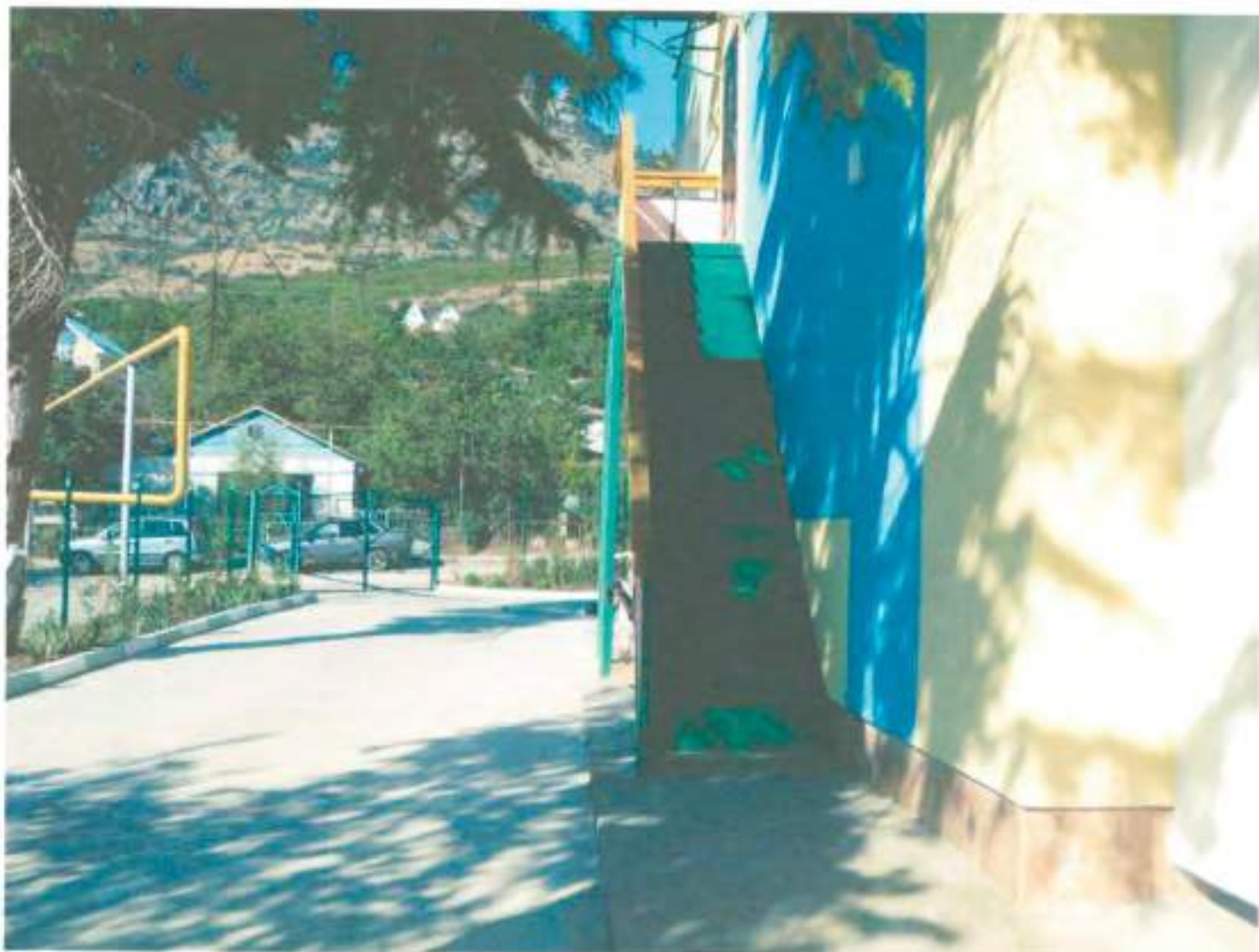
Фото 9 На плане отмечено 9 Описание: лестница наружная
