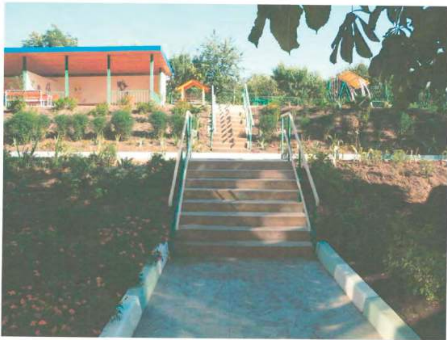
Фото 6 На плане отмечено 6 Описание: лестница наружная
