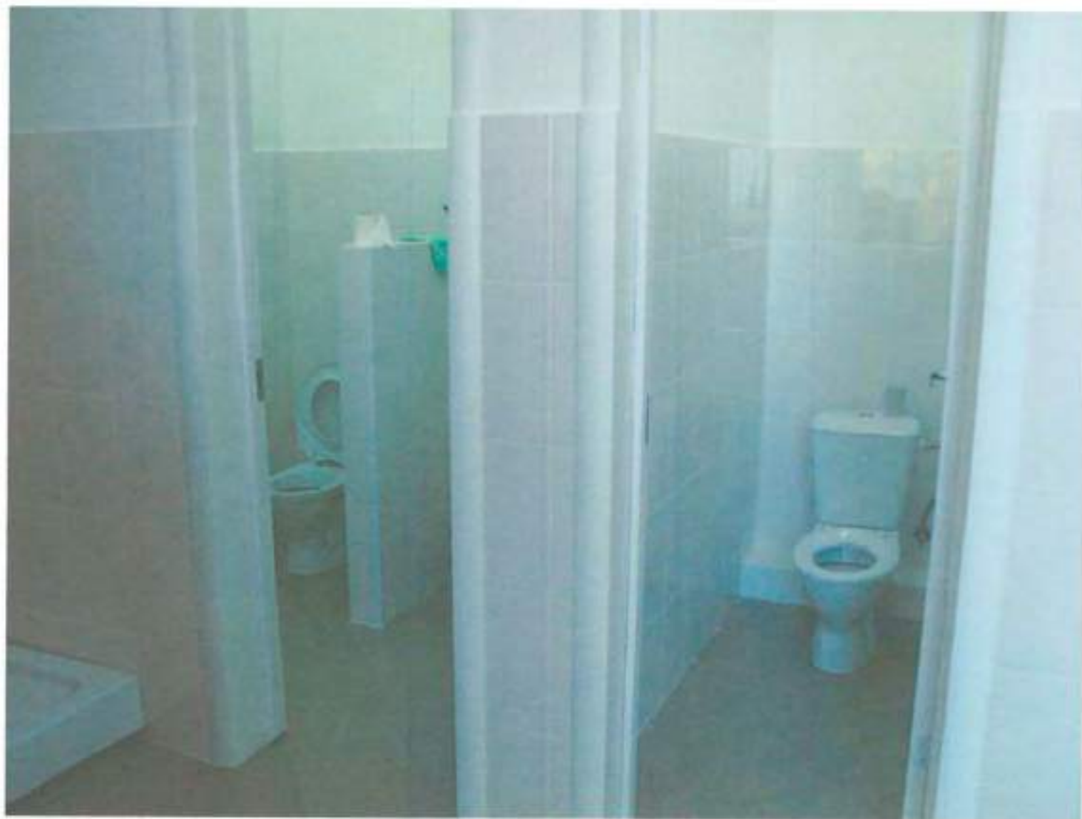
Фото 29 На плане отмечено 30, 35 Описание: туалетная комната
